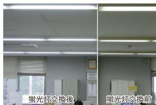
工場、管理棟、倉庫棟などに設置していた蛍光灯・水銀灯 2,624 台を撤去、新たに高効率照明ランプ、反射板付き 1 灯型省エネタイプ 2,232 台に変更しました。これにより、年間消費電力は 624,551kwh から 303,800.6kwh となり、320,750.4kwh 削減、CO<sub>2</sub> 排出量は年間 123tCO<sub>2</sub> 削減されます。また、事務棟のカフェテリア、および玄関ホールの照明器具を白熱灯から蛍光灯タイプへ 199 個切り替え、1 灯あたりの寿命が 600 時間から 6,000 時
