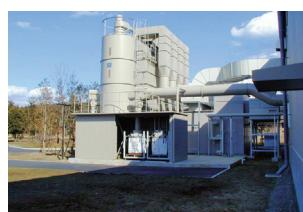
加工の段階で排出される大量の木屑を工場内のダクトで集塵機に集め、「空気」と「木屑」に分別、この「空気」を浄化し、工場内の空調（暖房）に循環利用しています。
